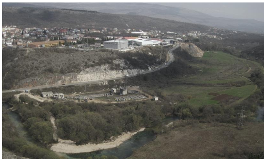
Slika 2: Lokacija postrojenja za prečišćavanje otpadnih voda
