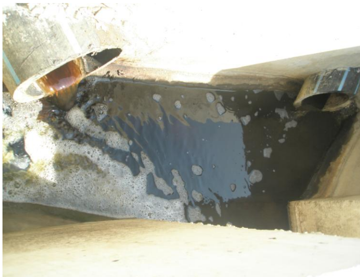
Slika 1. Procjedne vode na sarajevskoj sanitarnoj deponiji – sabirni šaht
