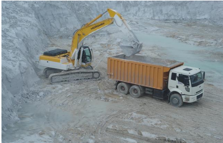
Slika 3. Izvlačenje materijala iz taložnice „Bijelo more” koja nije u upotrebi
