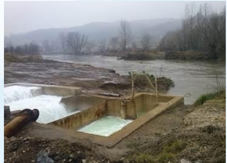
Preliv taložnice „Bijelo more” broj 2 i 3 u rijeku Spreču
