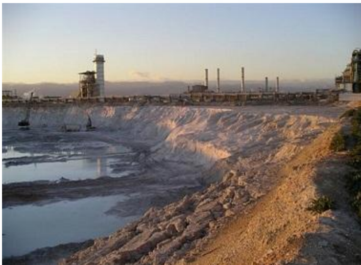
Izvlačenje materijala iz taložnice „Bijelo more“ koja nije u upotrebi
