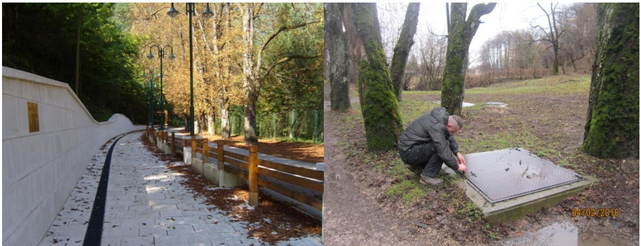
I.Fijakersko stajalište Vrelo Bosne prije i nakon izgradnje, te lokacija na kojoj se nalazi uređaj
