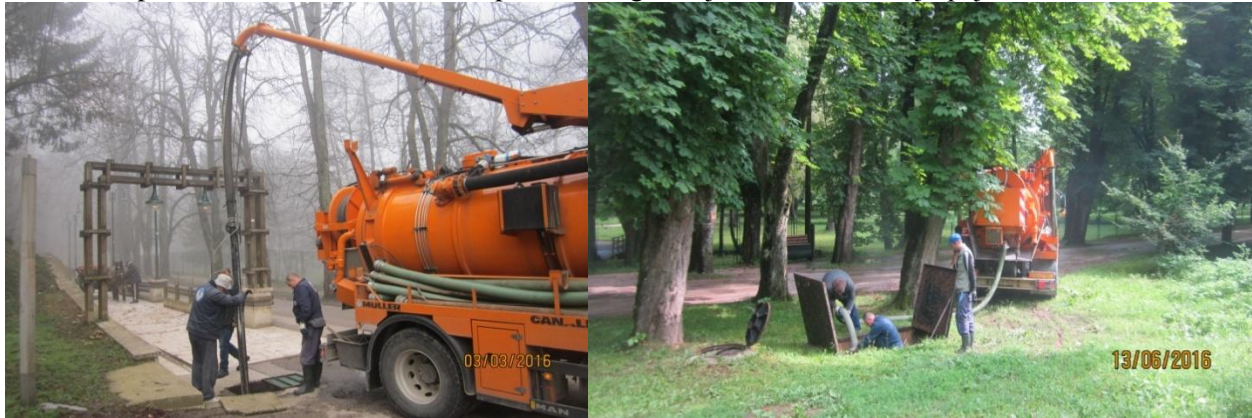
IV. Crpljenje otpadne vode, čišćenje sabirnih slivnika i separatora, Vrelo Bosne
