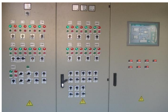
Slika broj 2 Nadzorno-komandni ormar u objektu "402"
