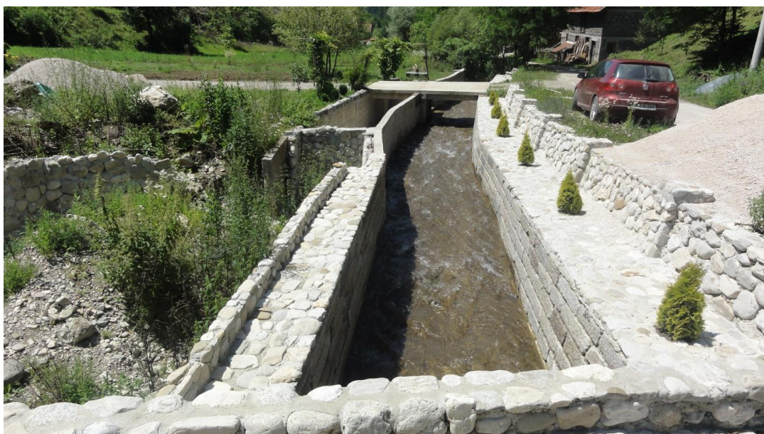
Slika 8.-9: Potporni zidovi uz Gračaničku rijeku (VT 419114)
