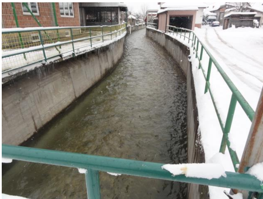
Slika 8.-6: Potporni zidovi i kuće uz Tilavu (VT 406232)
