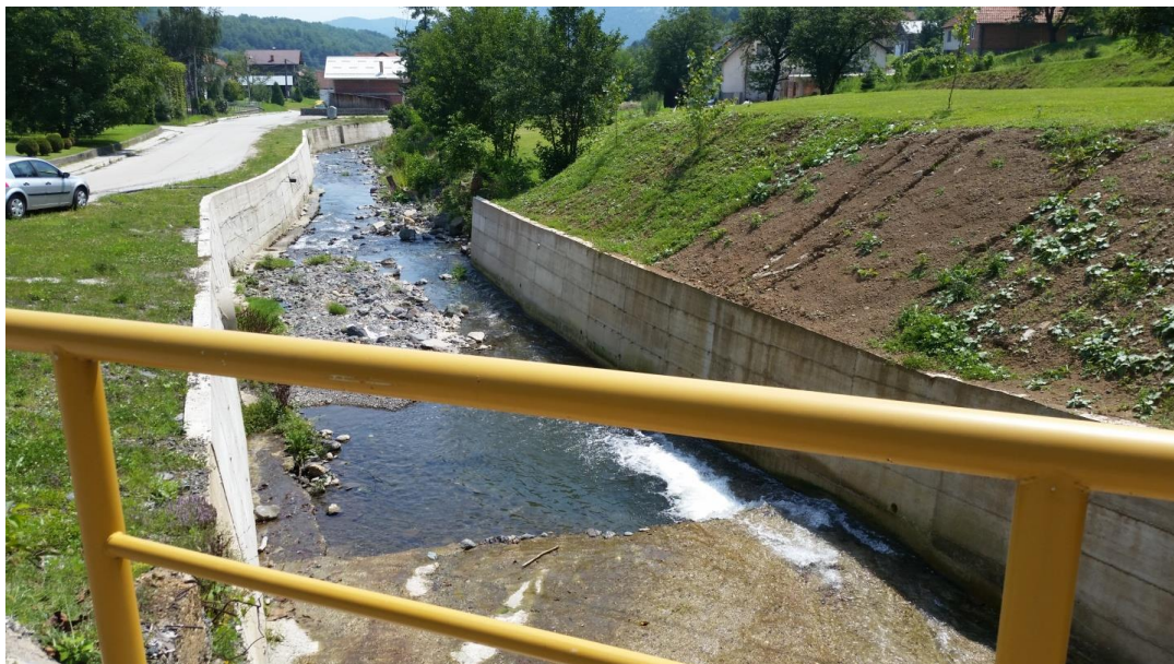
Slika 8.-10: Potporni zidovi uz Papratnicu (VT 422119)
