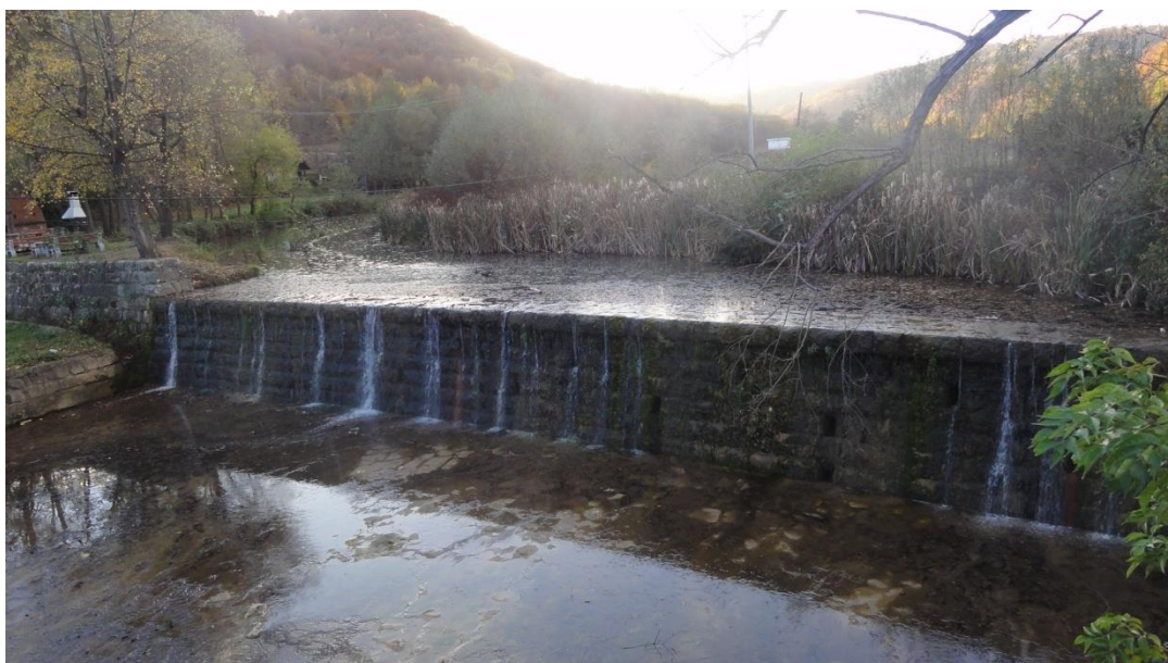
Slika 8.-26: Kaskada u koritu Šibošnice (VT 107054)
