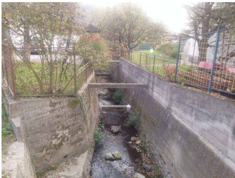
Slika 8.-3: Potporni zidovi na Ljubači (VT 50186)
