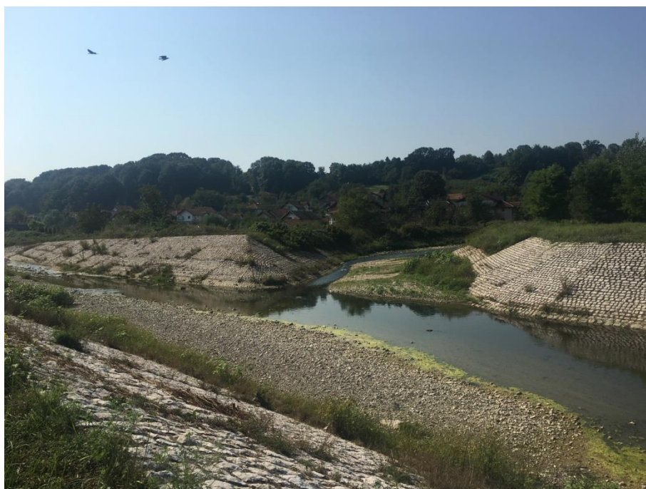
Slika 8.-27: Regulacija korita na ušću Moraštice (VT 106036) u Tinju (VT 106029)
