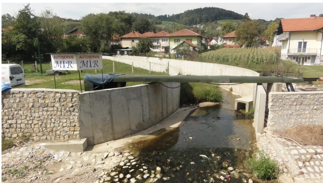
Slika 8.-5: Potporni zidovi na Sokoluši (VT 403245)
