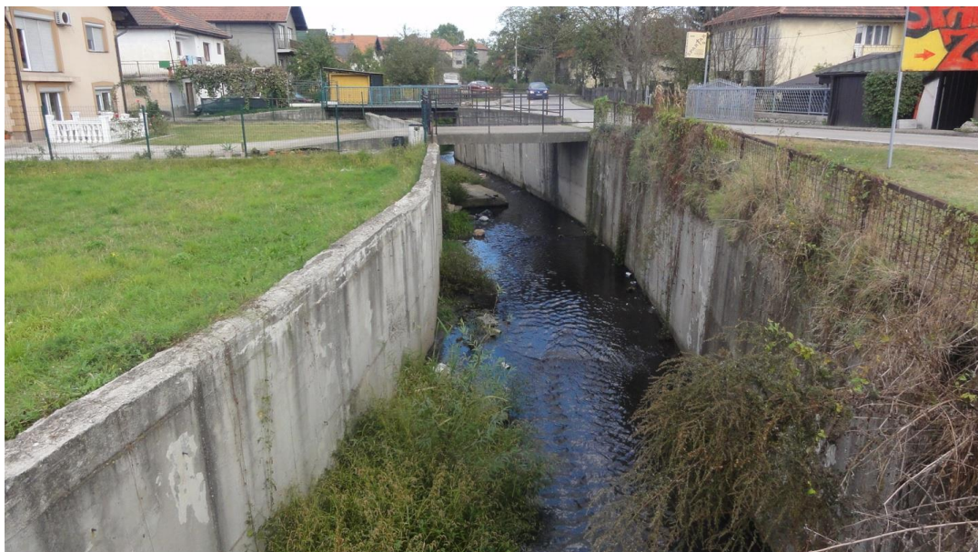
Slika 8.-2: Potporni zidovi na Lukavačkoj rijeci (VT 50132)
