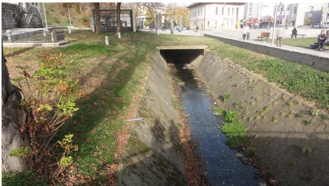
Slika 8.-28: Regulacija korita Gradašnice (VT 109060)
