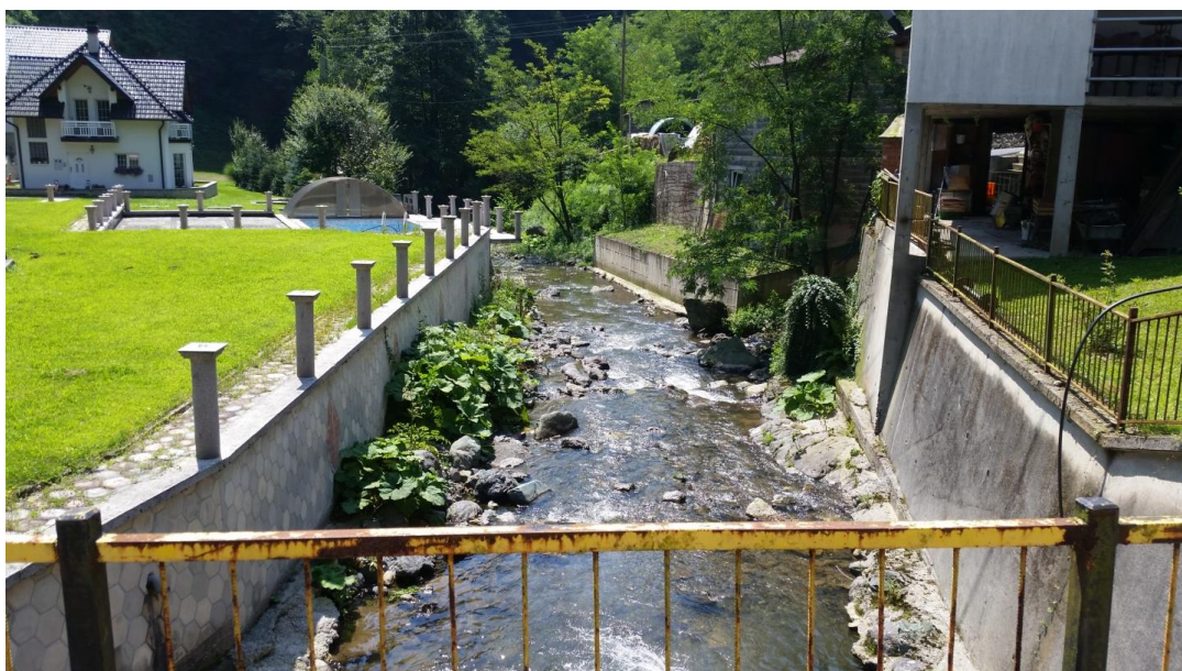
Slika 8.-11: Potporni zidovi i kuće uz Papratnicu (VT 422119)
