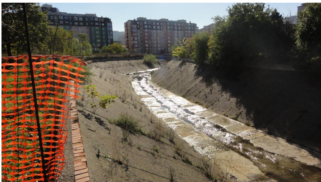
Slika 8.-17: Regulisano korito Soline (VT 403256) i ušće u Jalu
