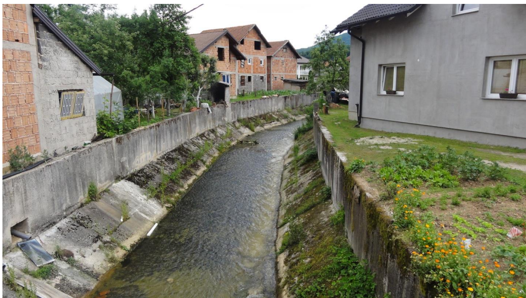
Slika 8.-8: Potporni zidovi i kuće uz Ivančicu (VT408083)
