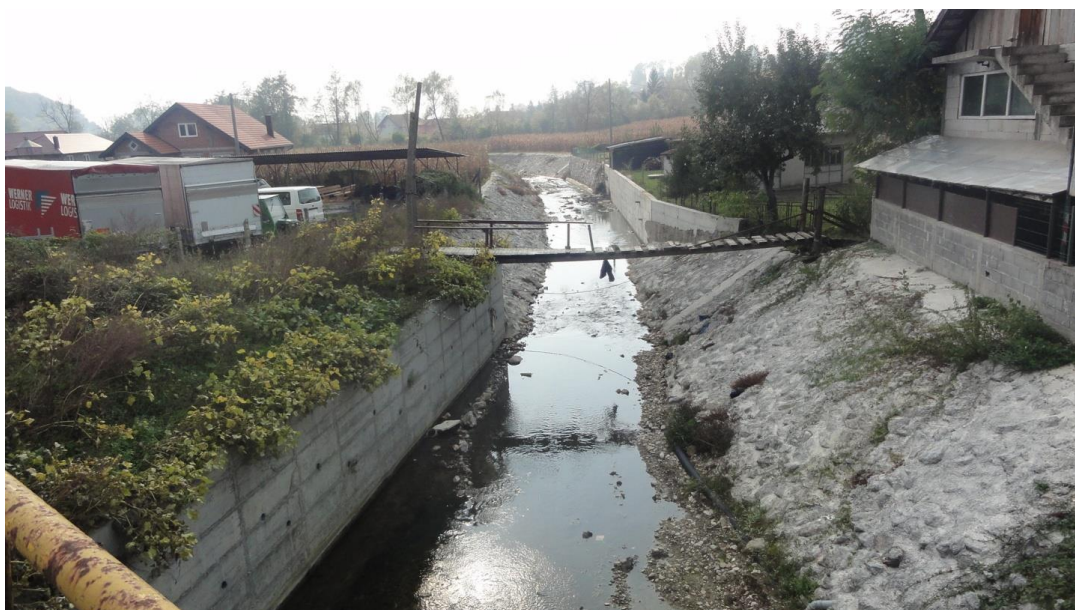
Slika 8.-4: Potporni zid i obaloutvrda na Gribaji (VT 403257)
